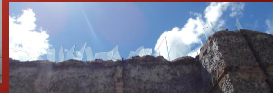
塀の上にはガラス片
